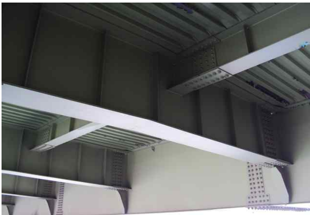
거더 및 가로보,세로보 상태양호
